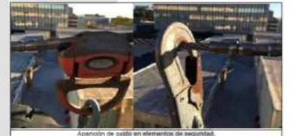
Aparición de oxido en elementos de seguridad.
